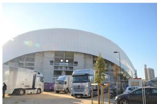
Novembre 2013 - 1er location d'un groupe électrogène au Stade vélodrome de Marseille
