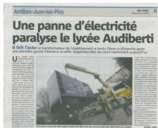
Avril 2013 - Dépannage express au Lycée Audibert, location d'un 350 et 100 kva
